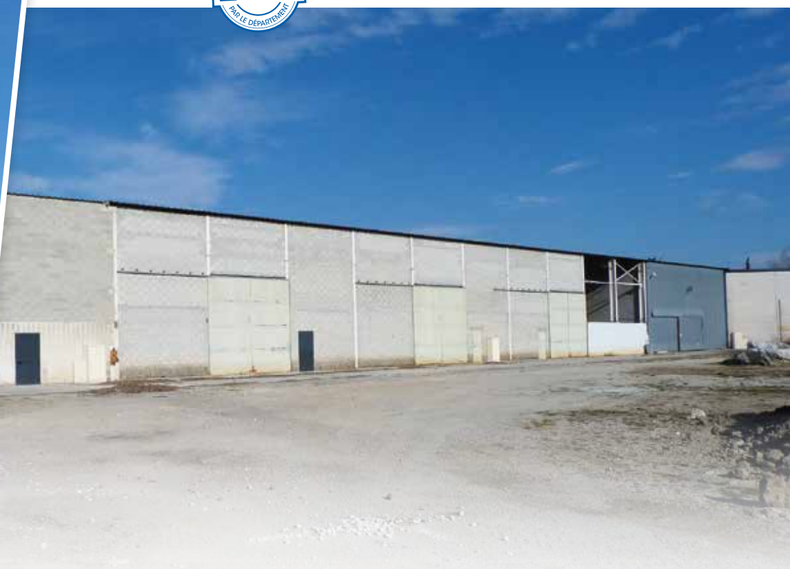
Démarrage de la viabilisation du site « les 3 vergers »
