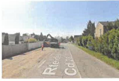
Entrée par la route de Châteaurenard, au nord : à droite un paysage arboré et un bâtiment en pierre rappelant l'identité villageoise du territoire ; à gauche une zone pavillonnaire murée.
